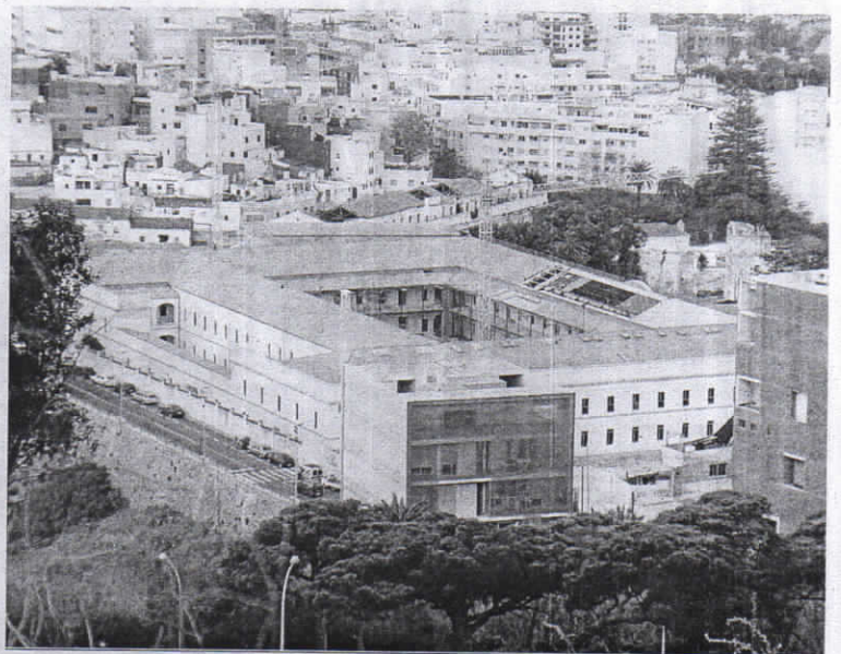
Las obras del campus terminarán este trimestre y estará funcionando a pleno rendimiento en septiembre. EL FARO
