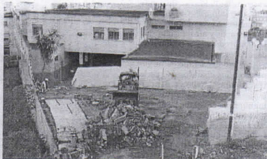
Estado del patio interior del CEIP Rosalía de Castro.
