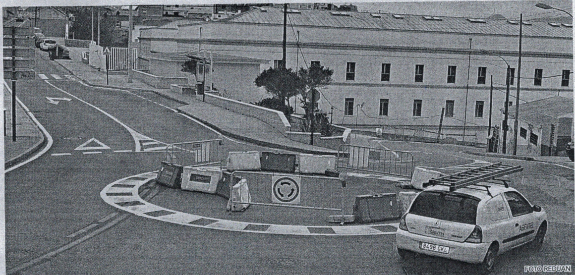
Las obras de una nueva rotonda en Pozo Rayo para acceder al Campus ya están en marcha /11
