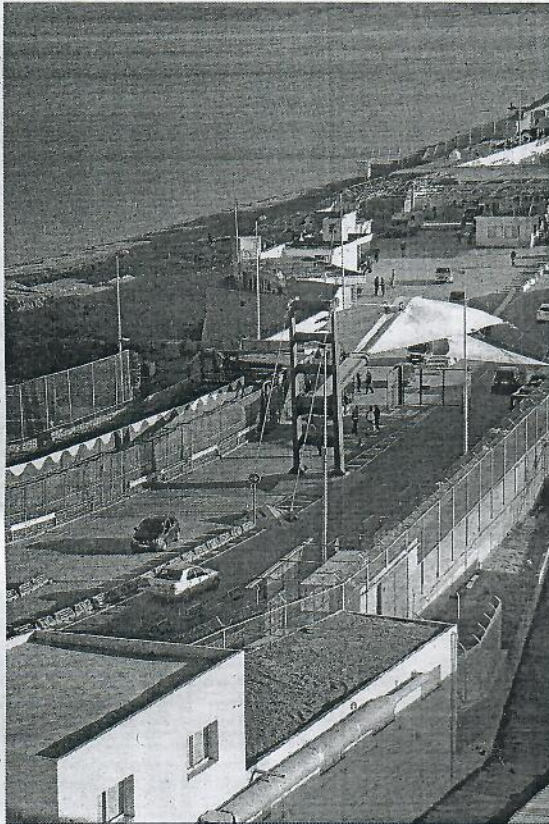
Las obras deben compaginarse con mantener el paso abierto.
