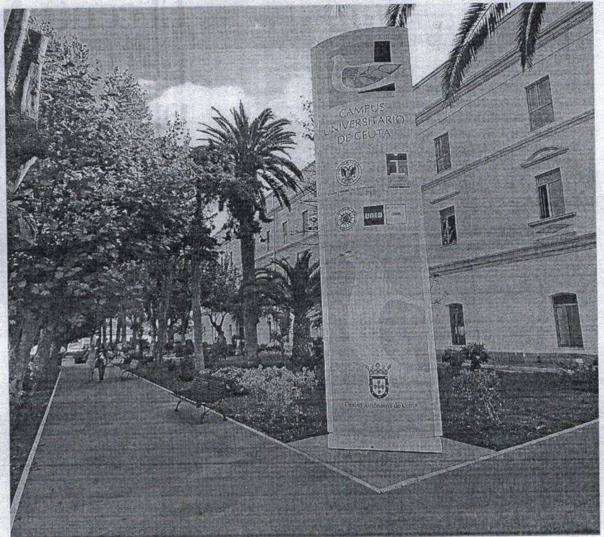
Esperan que las obras de acondicionamiento para el laboratorio comiencen el próximo febrero.
