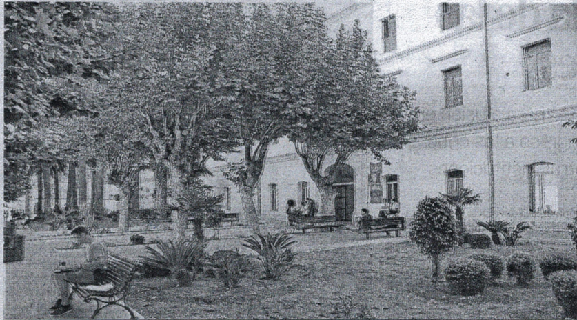
Pronto se terminarán todas las obras.
