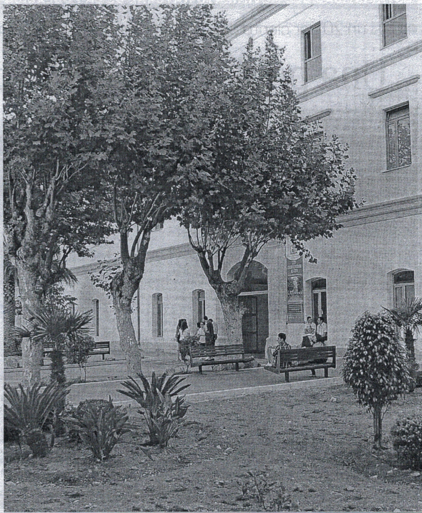
En la cubierta del edificio anexo irá la nueva instalación.
