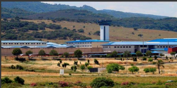
Imagen 3. Centro penitenciario de Botafuegos (Algeciras, Cádiz).
