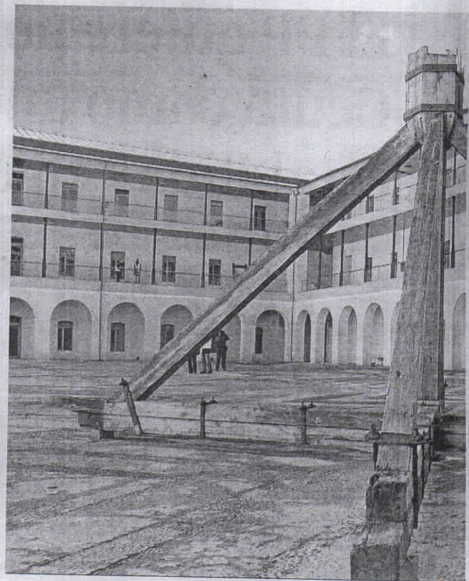
Pendolón de madera restaurada que se ha conservado y que permanece expuesta en el patio
